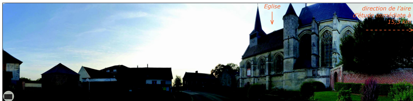
Vue panoramique sur l'église de Folleville, dans le centre-bourg
